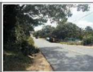
Vista da Estrada
