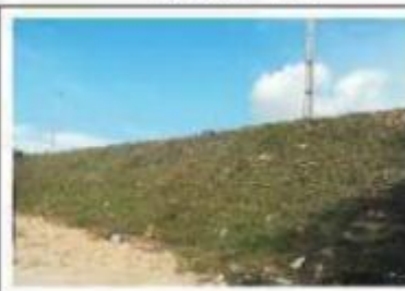
Talude do Platô
